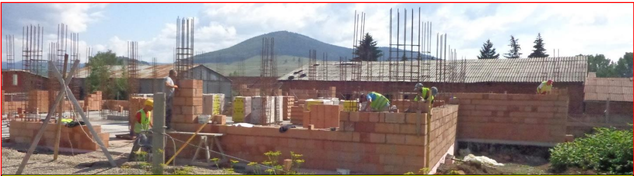
Zufriedenstellender Ablauf auf der Baustelle! Stand der Baumaßnahme Mitte 2017.
